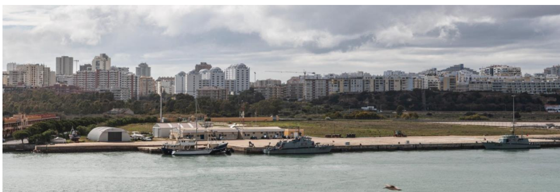
Figura 5.14.1 - Vistas para Portimão a partir de Ferragudo. Em primeiro plano o Ponto de Apoio Militar de Portimão, o Heliporto e o Porto Comercial de Portimão, e, em último plano a massa construída de Portimão que pela sua densidade e volumetria constitui uma forte barreira visual que delimita a bacia visual. Entre estes dois planos localiza-se a área do loteamento, sendo bem patente a importância da vegetação para atenuar um pouco a leitura da mancha contínua do edificado.
